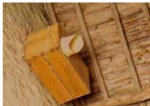
Dispositif anti-fouine réalisé à l'aide
